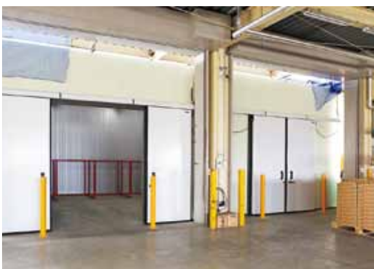
4月14日に完成した予冷庫。6月から稼働する。
