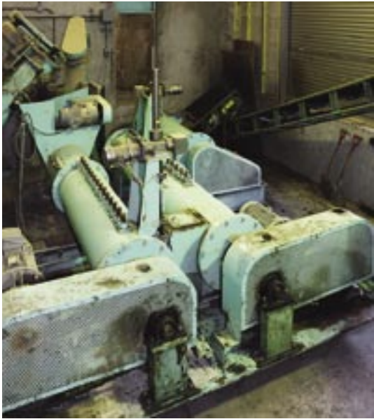
ちからくんたい肥のプラント。圧縮・粉砕作業を行います。
